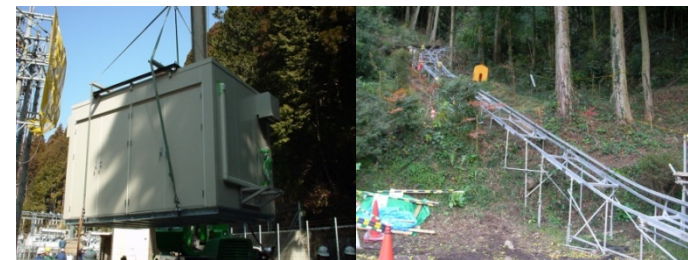
大型アッセンブリー 現地据付
